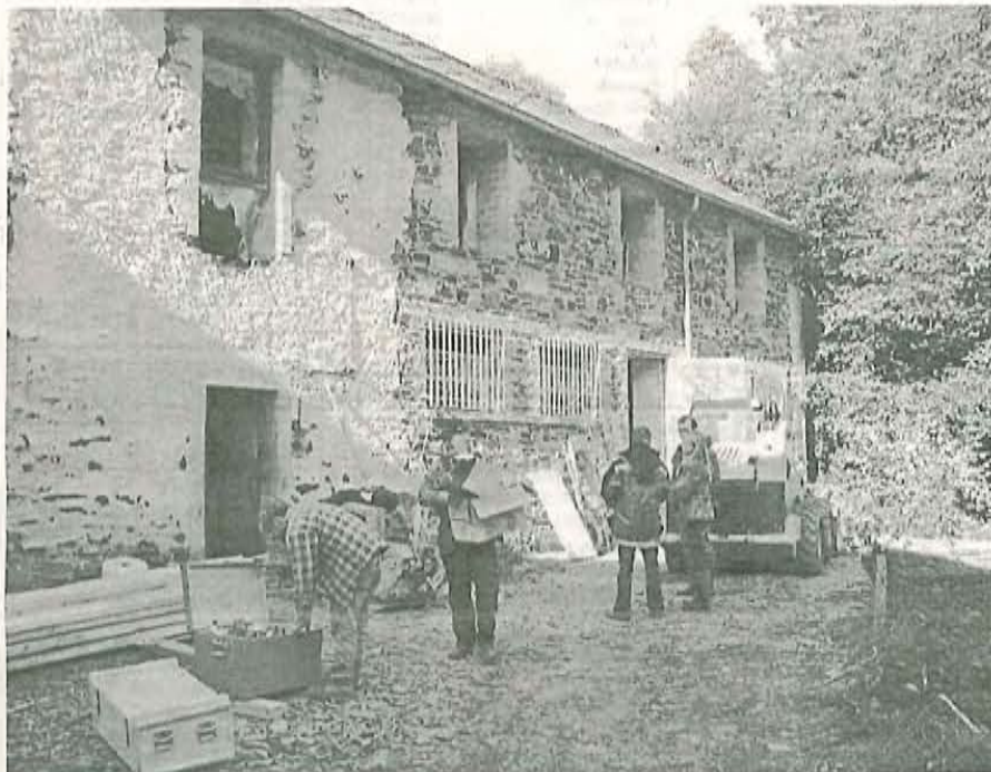
Réunion de chantier devant l'écurie du moulin de Kalborn
