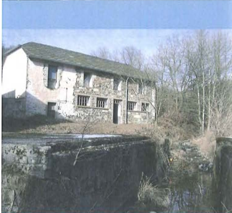
Vor den Renovierungsarbeiten
