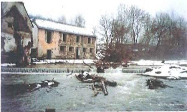
Das Gebäude im tiefen Winter vor den Renovierungsarbeiten
