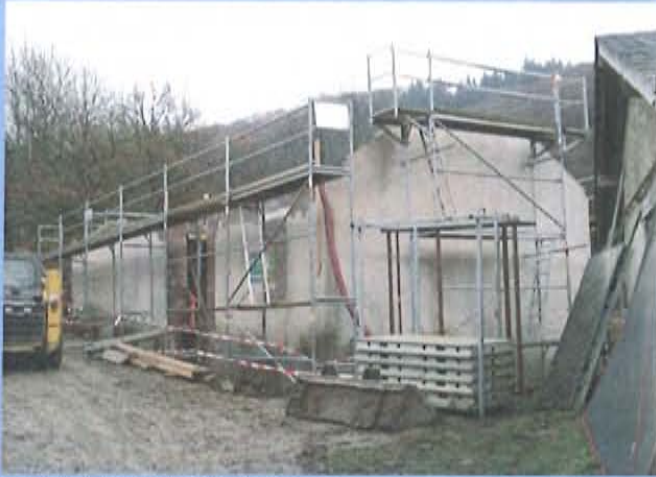
Das Dach wurde bereits abgetragen
