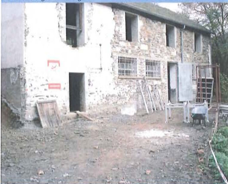
Die Renovierungsarbeiten beginnen
