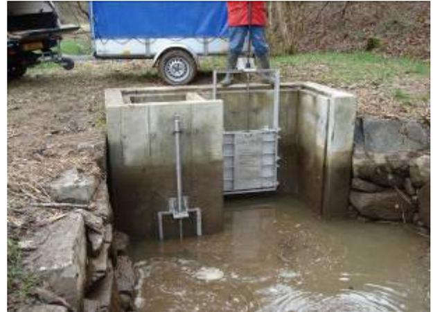
Vannes permettant de régler le débit
