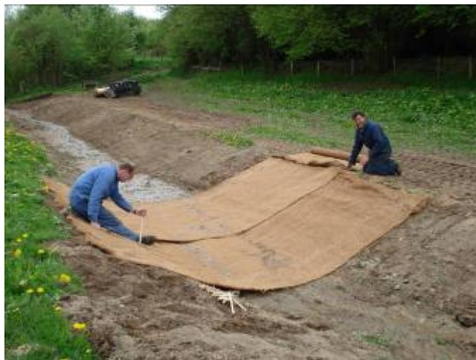
Installation d'un géotextile.
