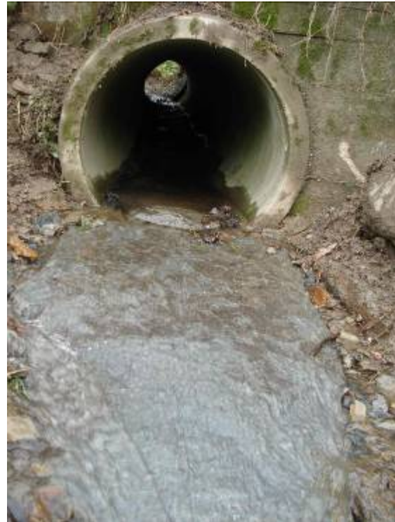
Kenzelbach 6.4 sortie (géotextile installé).
