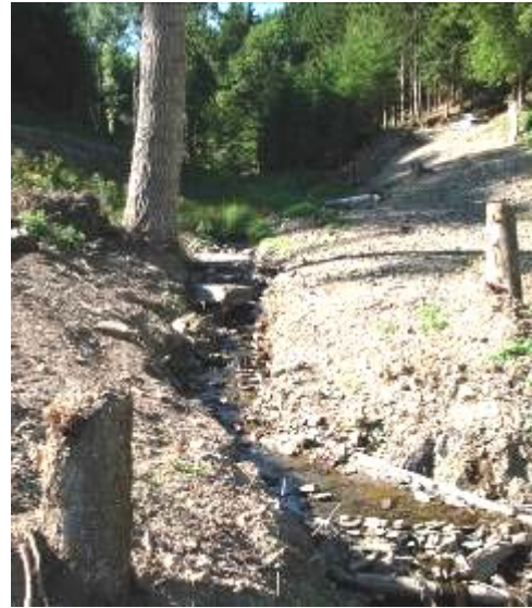
Obstacle enlevé, et passage abandonné par réaménagement des rives.
