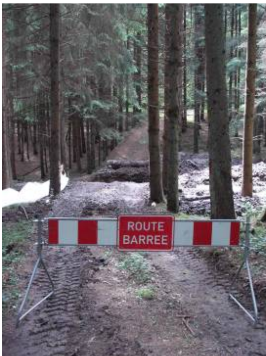
Tuyaux enlevés et préparation du chantier en vue de la pose du tube en tôle.
