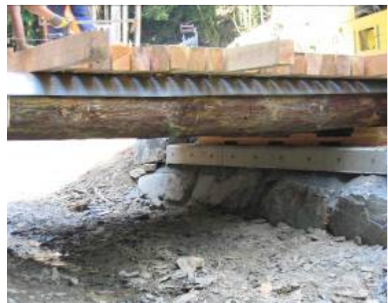
Vue sur le fondement du pont.
