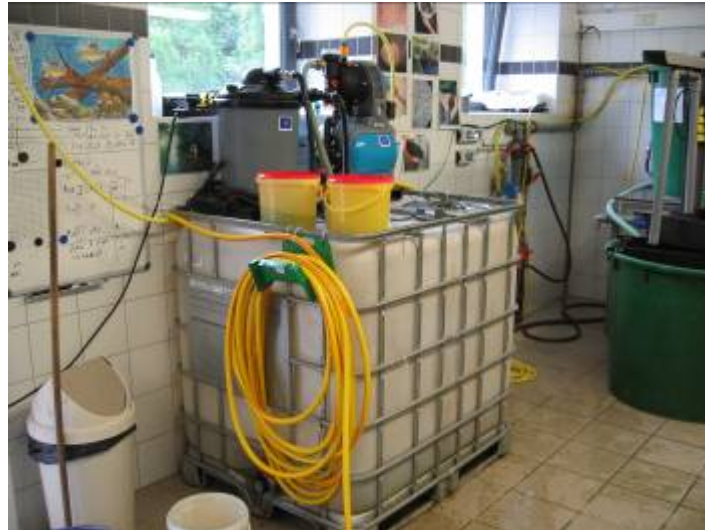
Système de filtration d'eau avec filtre biologique.
