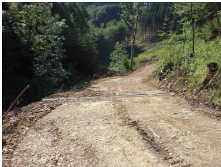
Rigoles à évacuation de l'eau sur le nouveau chemin.
