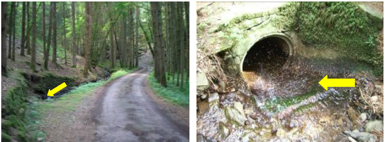
Vue sur la partie amont de l'obstacle.
