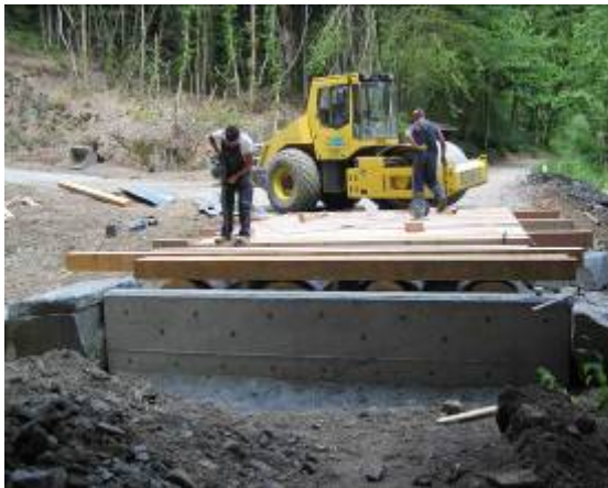
Installation du pont en bois.
