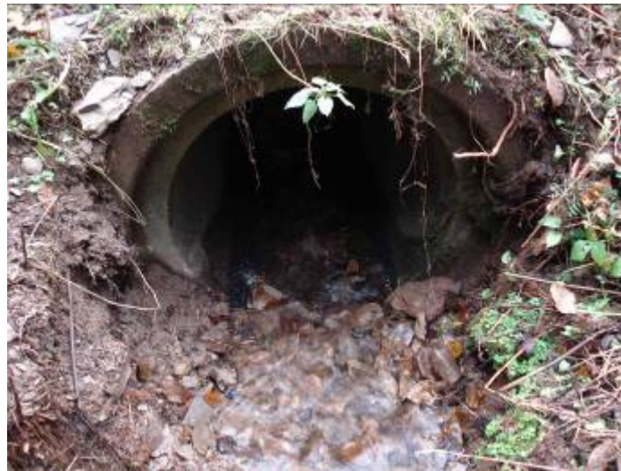
Tuyau après sa transformation (entrée).
