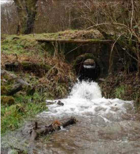
Obstacle 6.4 avant transformation.
