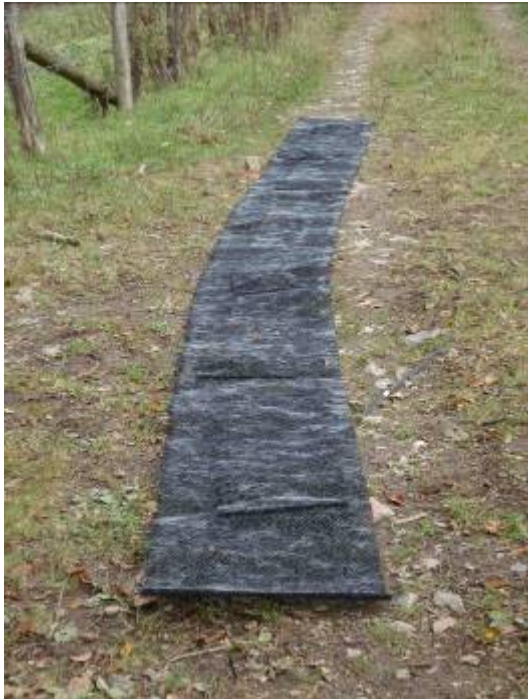
Vue sur le géotextile déroulé.
