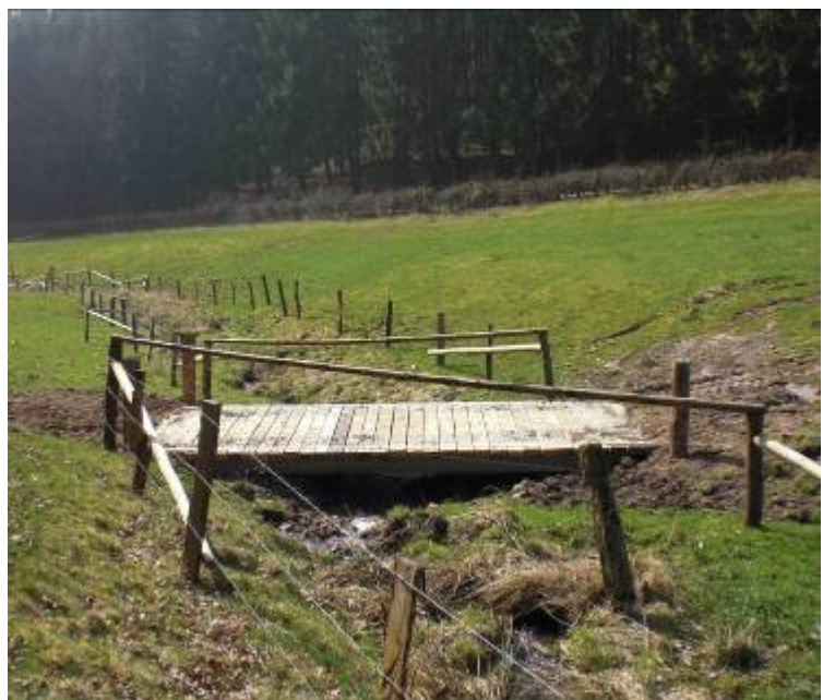
Passé à bétail et clôture sur la Grondbaach (affluent de la Kenzelbaach ).
