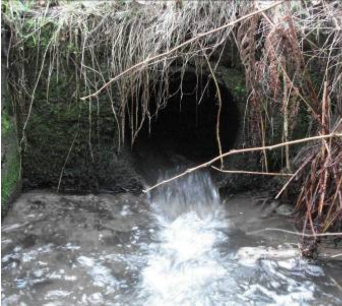
Vue sur l'obstacle avant transformation (présence d'une faible chute).
