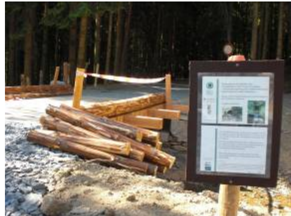
Panneaux de chantier installé près du chantier de construction d'un pont.
