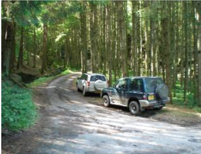
Tracé actuel du cours d'eau en dessous du chemin rural. Epicéas à enlever (parcelle à droite).
