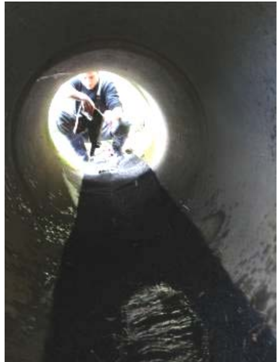
Fixation du géotextile dans le tuyau.
