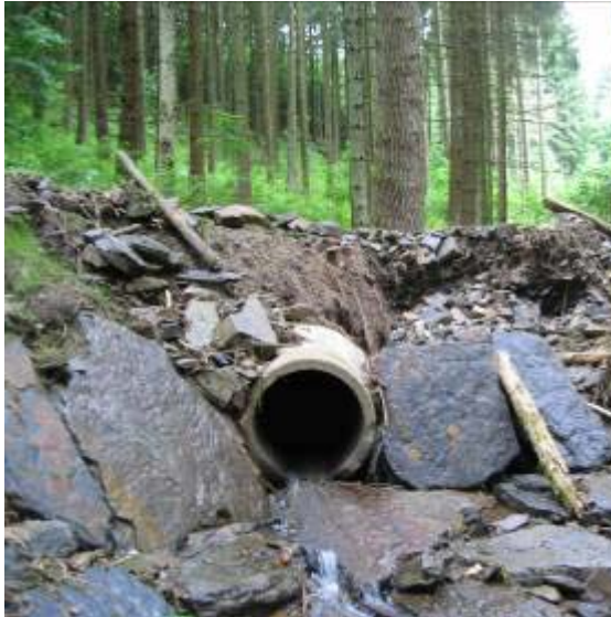
Situation initiale : obstacle 2.2 à enlever.
