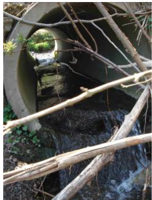
Installation d'un géotextile (nécessite encore un finissage pour supprimer la chute).
