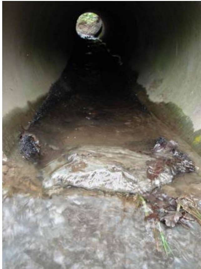
Kenzelbaach 6.4 vue intérieur (géotextile installé).
