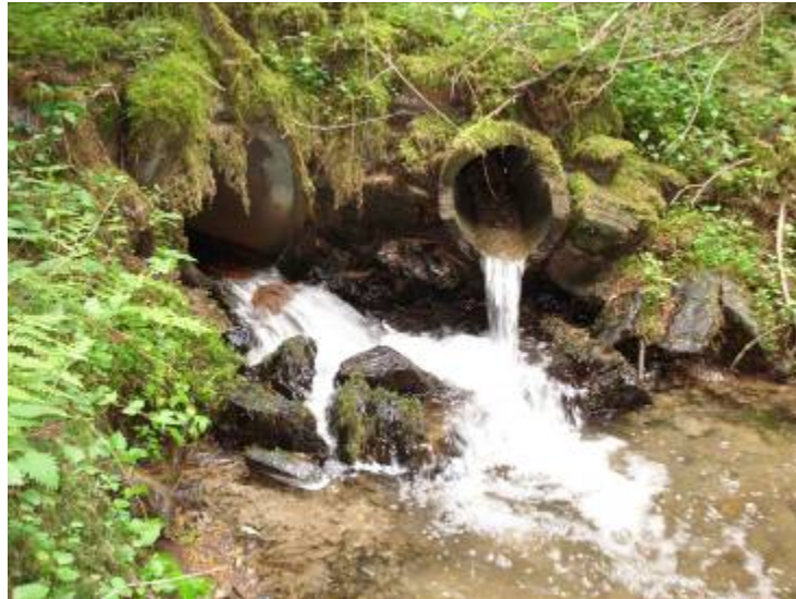
Situation initiale: obstacle 5.1 à enlever.
