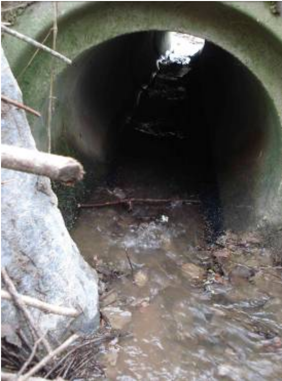
Kenzelbach 6.4 entrée (géotextile installé).
