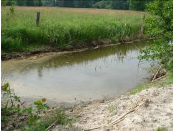
Bassin de rétention de sédiments. Il est vidé une fois par an.
